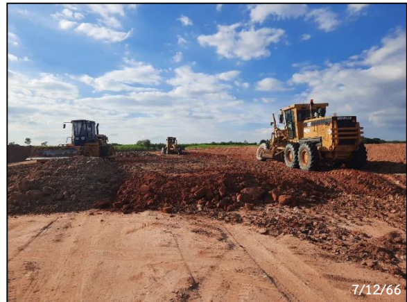
รูปที่ 2-63 กิจกรรม Embankment Fill กม.9+200 - 9+720
