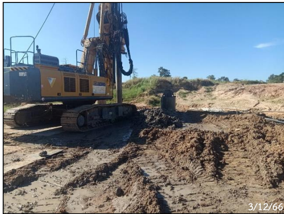
รูปที่ 2-41 กิจกรรมตอกเสาเข็มสะพานรถไฟข้ามแม่น้ำยัง
