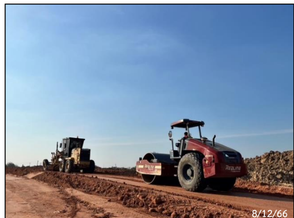
รูปที่ 2-36 การปรับเกลี่ยหน้าดิน และบดอัดหน้าดิน
