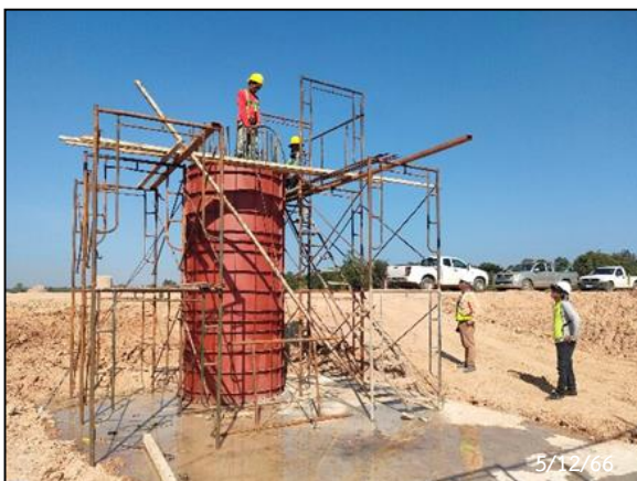
รูปที่ 2-66 กิจกรรมเทคอนกรีตเสาตอม่อสะพานรถไฟ ข้ามลำน้ำ กม. 153+062
