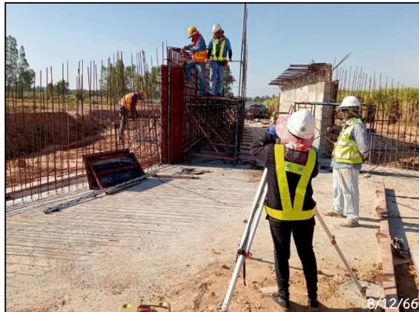
รูปที่ 2-43 การก่อสร้างทางลอด (Box Underpass)
